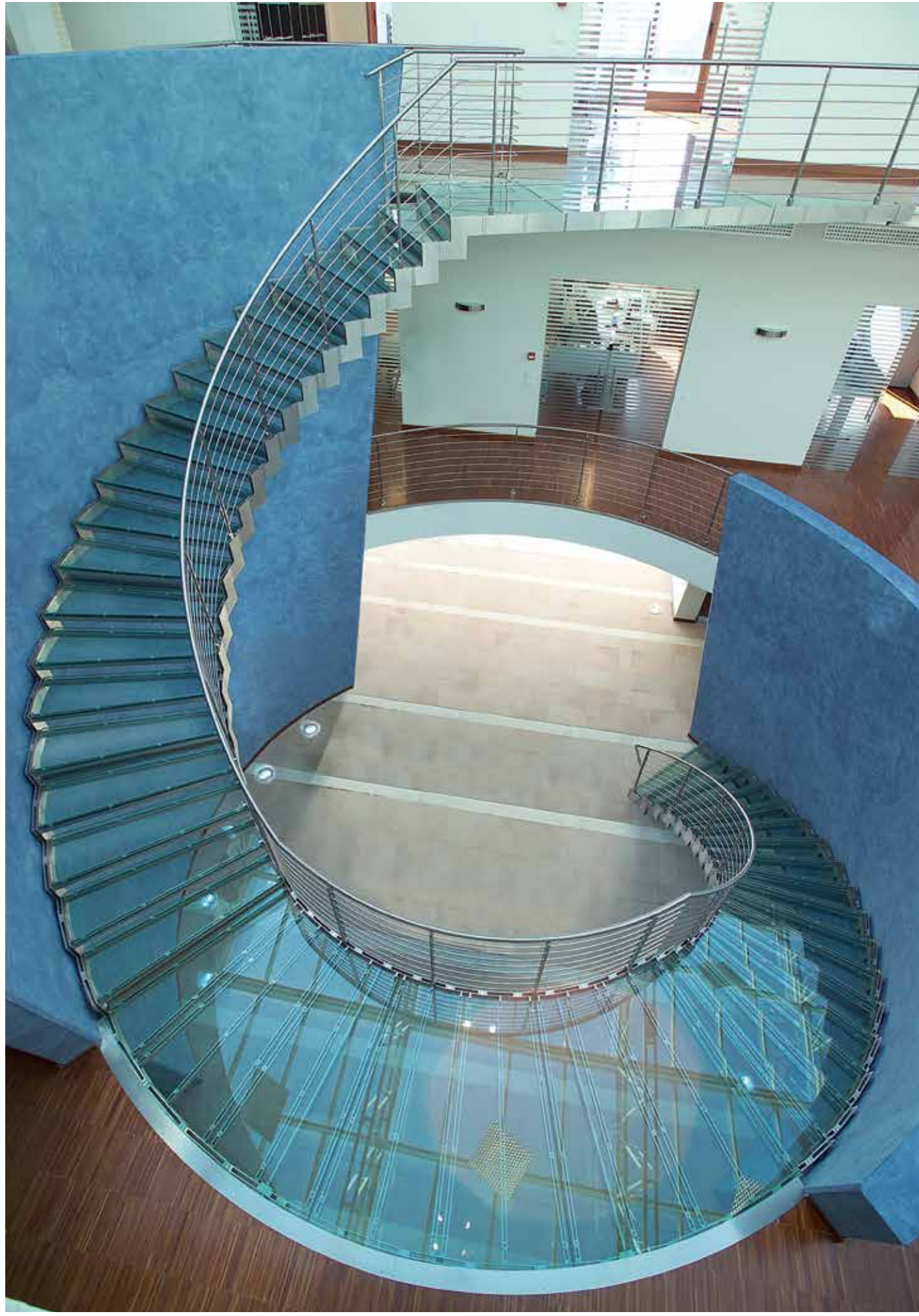
Scala elicoidale con struttura laterale modulare in acciaio inox e gradini in cristallo stratificato float e ringhiera a rondini orizzontali in acciaio inox. Helix-shaped staircase with modular stainless steel structural side strips, steps in stratified float glass and banister in horizontal stainless steel rods. Escalier hélicoïdal à limon latéral modulaire en acier inox et marches en cristal feuilleté float et garde-corps à lisses horizontales en acier inox. Spiralförmige Treppe mit modularem seitlichem Tragwerk aus rostfreiem Stahl, Stufen aus Float-Verbundglas und Geländer mit horizontalen Rundstäben aus rostfreiem Stahl. Escalera helicoidal con zanca lateral modular de acero inoxidable y peldaños de cristal estratificado float; barandilla con barras horizontales de acero inoxidable.
