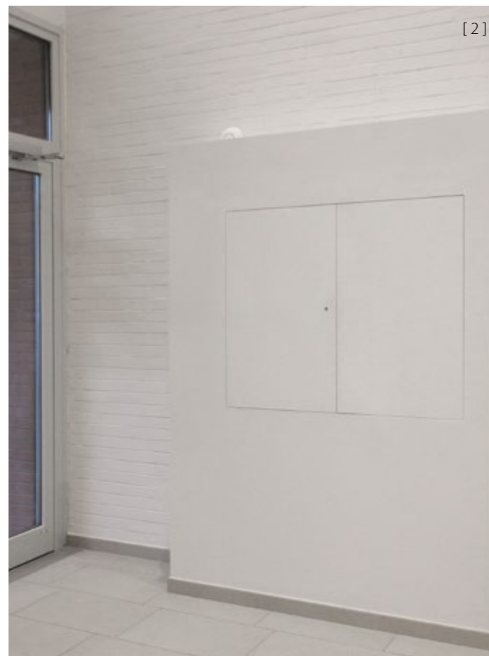
[ 1 ] Mino ad un'anta MDF per chiusura vano boiler. (Mino with one MDF door to close the boiler compartment.)
