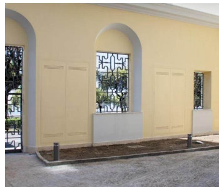
FANTASMINO CON ANTE S.A. (STRATIFICA DI ALLUMINIO) PER ESTERNO, COMPLETE DI LAVORAZIONI PER AREAZIONE.
