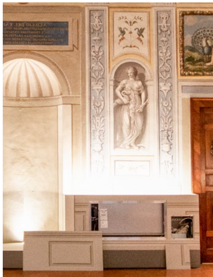
[2] Faint col per chiusura ventilconvettore senza areazione, posizionato nella boiserie di un palazzo storico. Faint col for fan coil closure without ventilation, located in the wood panelling of a historic palazzo.
